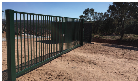
Exemple de portail avec barreaudage métallique vertical, vert foncé (crédit photo : Urbasolar)
